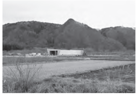
三陸沿岸道路（国事業）。宮古市田老から小本を結ぶ約6kmの自動車専用道路を整備中。(平成25年12月撮影)
