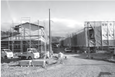
工事中写真（A・B棟）
