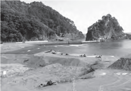
導流堤復旧工事 (平成 25 年 9 月撮影)
