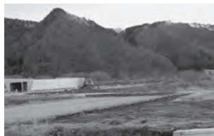
宅地造成工事（平成25年12月撮影）
