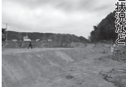
新設する山付堤防工事 (平成 26 年 1 月撮影*)
