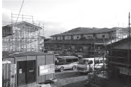
工事中写真（木造D・E棟）
