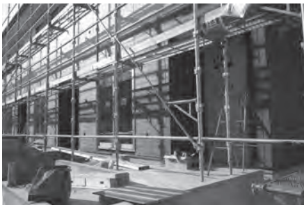
工事中写真（E棟玄関付近）
