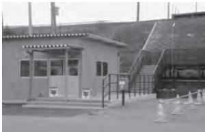
小本駅仮駅舎 (平成25年12月撮影)
