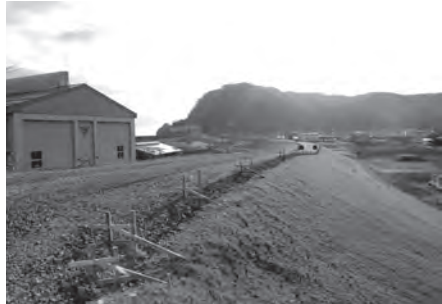
避難路工事 (平成 25 年 12 月撮影)
