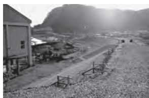
避難路工事（平成25年12月撮影）
