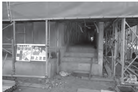
工事中写真（鉄筋コンクリート造A棟）
