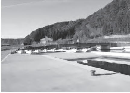
小本漁港かさ上げの様子。町の管轄でかさ上げ工事が行なわれている。(平成25年12月撮影)
