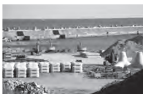
小本港の工事（平成25年12月撮影）
