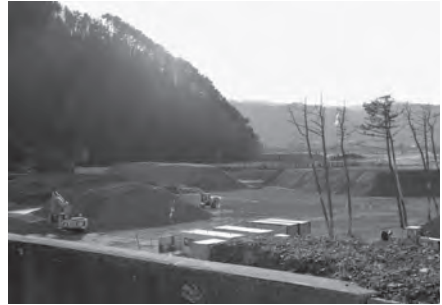
震災がれき置場の状況（平成25年12月撮影）
