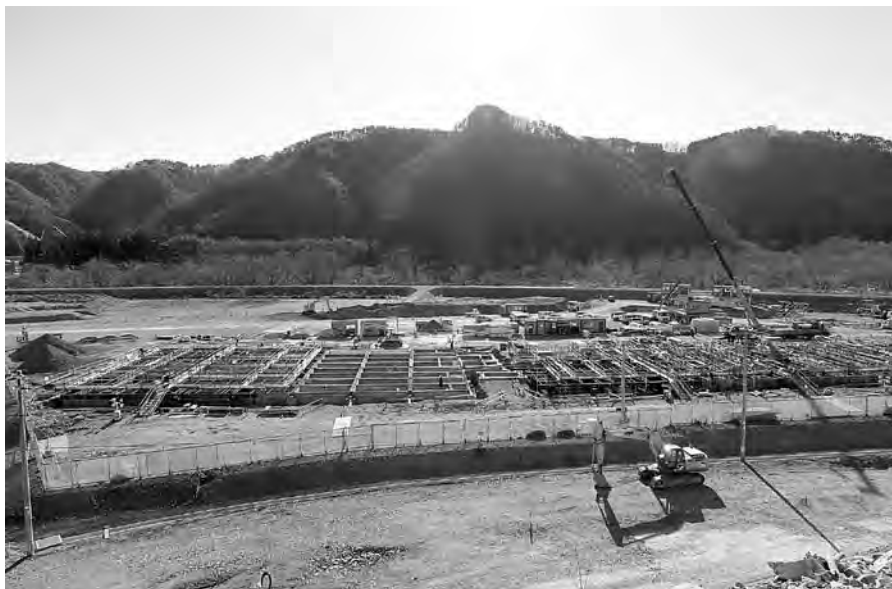
平成 26 年 12 月撮影 小中学校【工事中】
