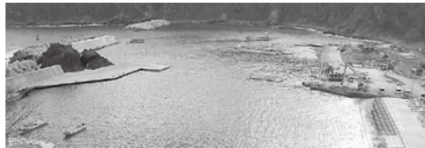
平成26年12月撮影 全景
