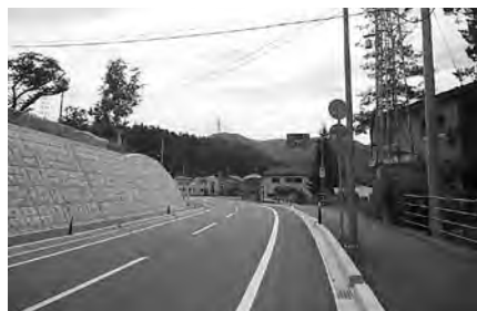
龍泉洞【施工後】
