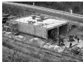
樋門据付【工事進行中】
