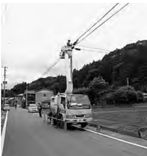
平成25年9月撮影 【光ファイバーケーブルの架設工事】
