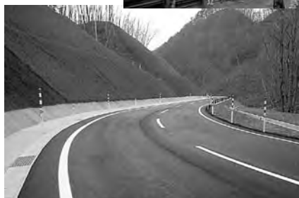
大月峠【施工後 - 一部区間】
