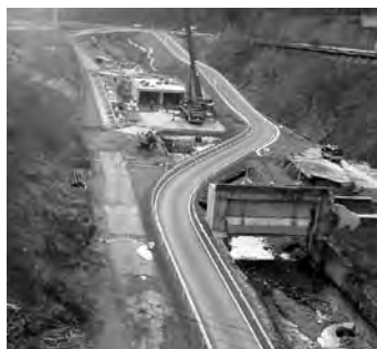
施工全景【工事進行中】
