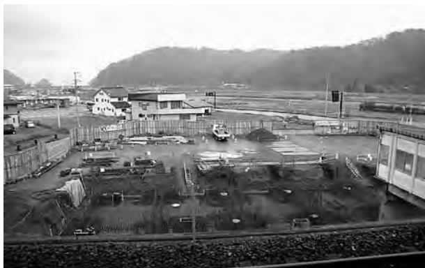
平成 26 年 11 月撮影【工事中】
