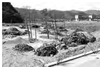
平成24年9月撮影【着工前】
