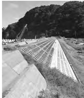
完成後（平成 25 年 8 月撮影）
