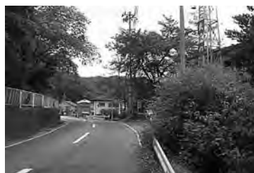
龍泉洞【施工前】
