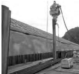
工事中 (平成 24 年 9 月撮影)
