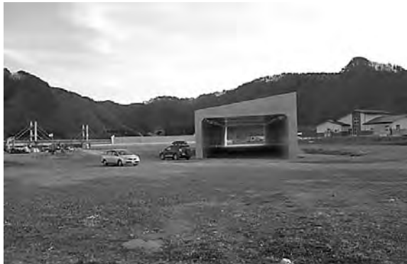
平成27年1月撮影 【工事中-函渠工完成】
