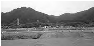
平成25年6月撮影 【工事中-施工ヤード造成中】
