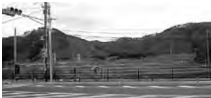
平成23年12月撮影 R455側から小本川方面【着手前】
