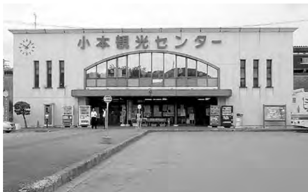
平成 25 年 12 月撮影 解体前の観光センター
