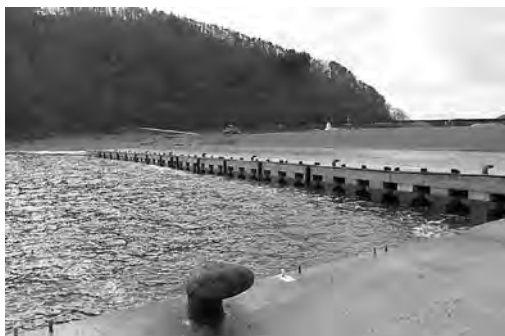
平成26年11月撮影 小本港【復旧工事後】
