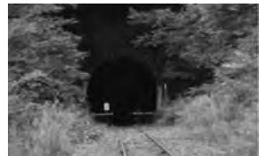
平成 25 年 9 月撮影 JR 岩泉線押角トンネル
