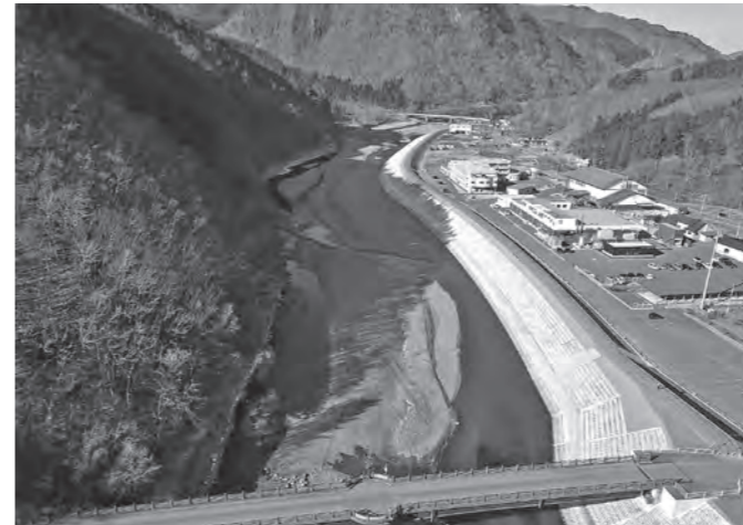
堤防整備と護岸工事はおおむね完了【乙茂地区】
