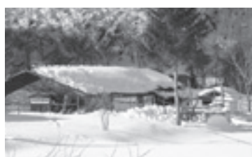
大雪に見舞われ除雪を待つ民家(安家地区)
