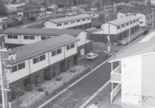
平成 26 年 4 月から入居が始まった 小本地区災害公営住宅
