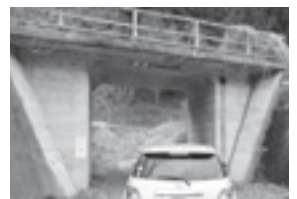
乗用車1台が、ようやく通過できる幅(尼額のボックスカルバート)
