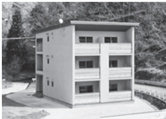
CLT製材で作られた建物(写真提供：銘建工業株)
