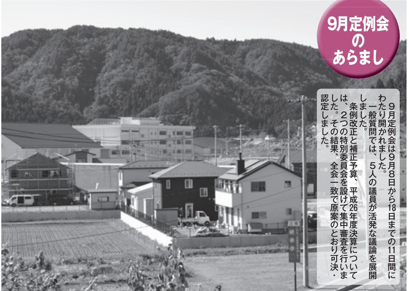
着々と進む小本地区の復旧（住宅建築が進む宅地造成地、奥が小本小・中学校）
