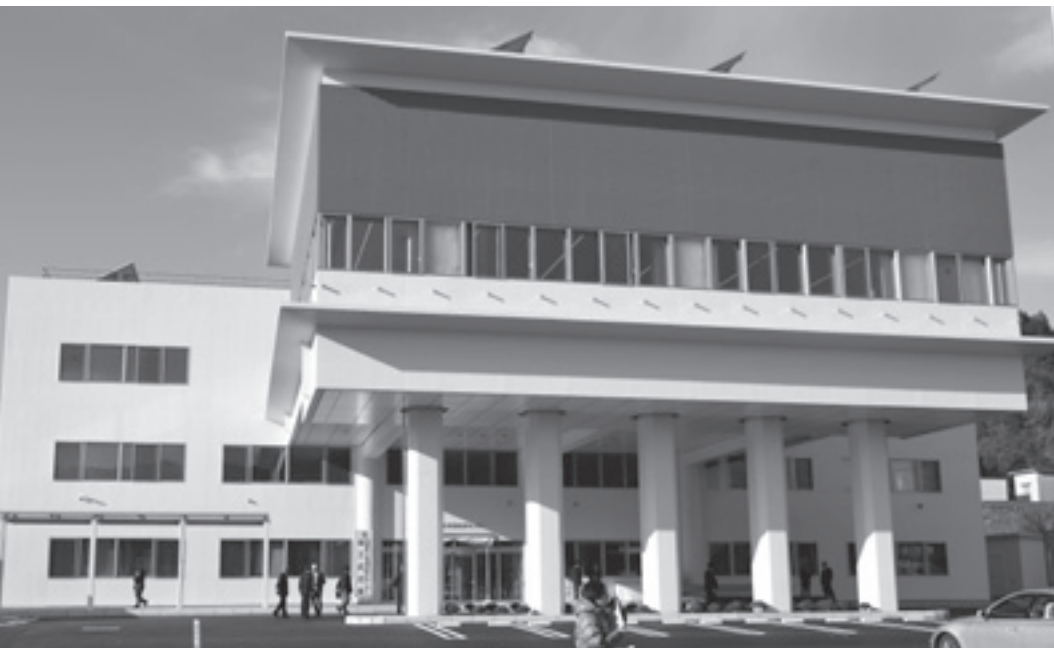
12月23日に竣工式 しゅんこう が行われた小本津波防災センター
