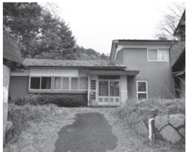
空き家を活用した早急な定住化対策が求められます
