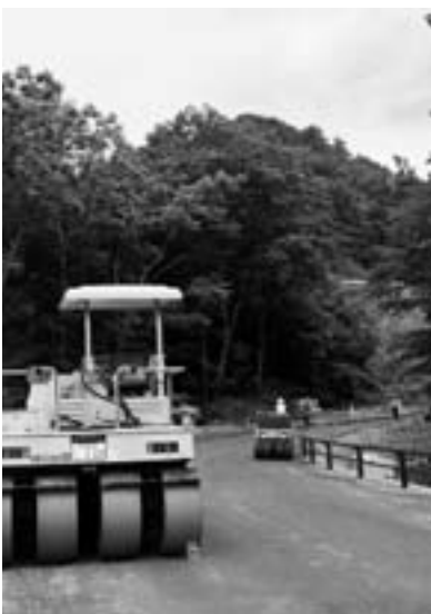
9月22日の供用開始を前に着々と工事が進む安家大月峠
