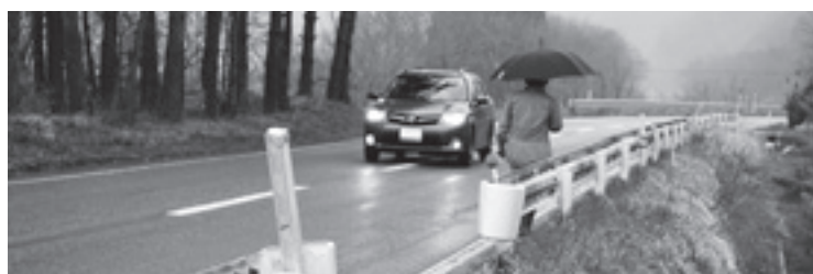
雨天時には特に危険な襲野・日向地区
