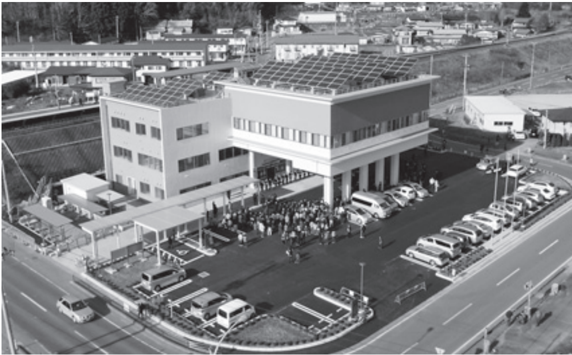
205 枚のソーラーパネルが設置された小本防災センター
