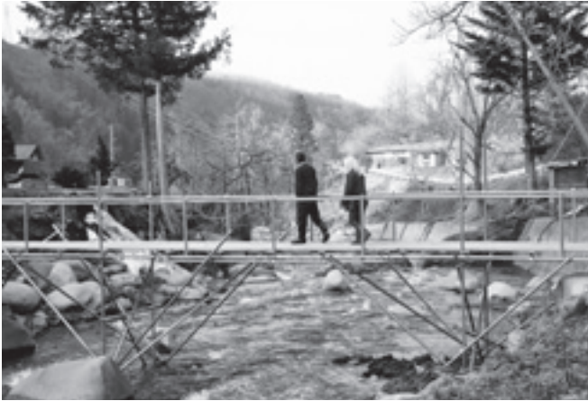
車は通れない仮橋
