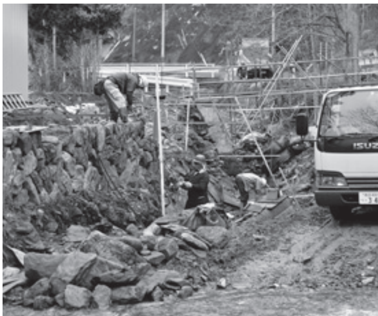
遅れが許されない災害復旧工事
