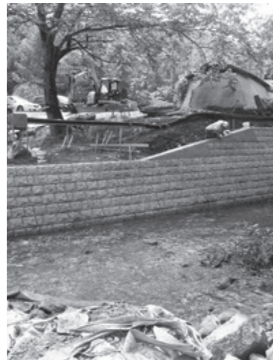
護岸工事が進む有芸
