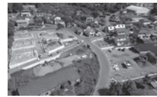
建築工事が始まった上町団地
