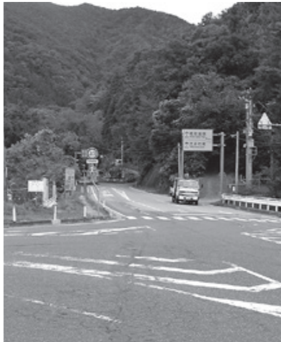
早期改良を望む国道 340 号
