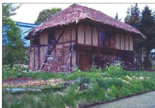
屋根材がワラの例
