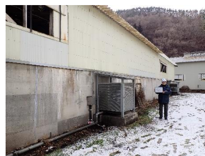
堆肥センター補修工事
