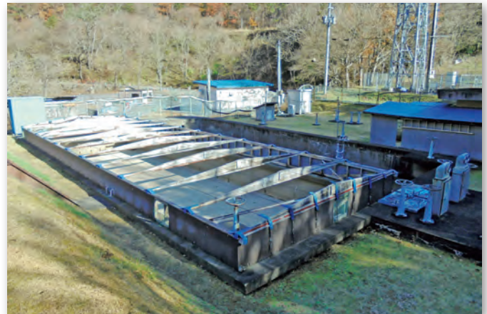
二升石浄水場
