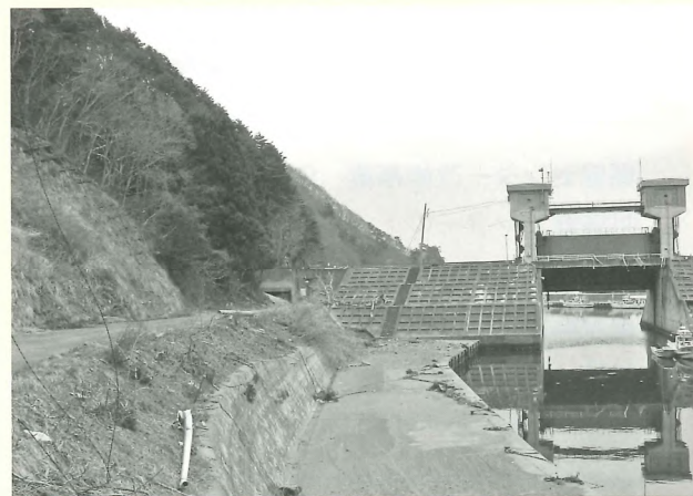
津波到達直前まで水門閉鎖に努め、水しぶきを浴びながら左側の山に避難しました（被災後の小本漁港水門）
